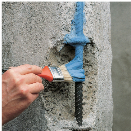
Bild 26. Rostskyddsbehandling
