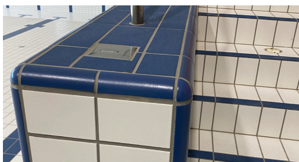
Bild 1. Keramiska kanter och ytterhörn rekommenderas vara rundade för att minska skaderisken vid kroppskontakt.
